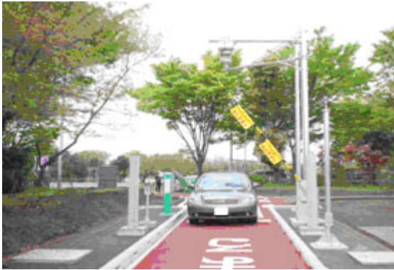
三芳スマート IC（関越自動車道）／国土交通省 HP より引用
